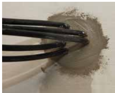
6 ... und dauerhaft abgedichtet.
