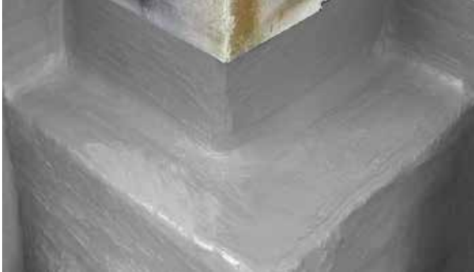
Fuß- und Sockelabdichtung
