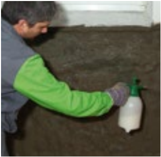
Grundieren mit KÖSTER Polysil TG 500
