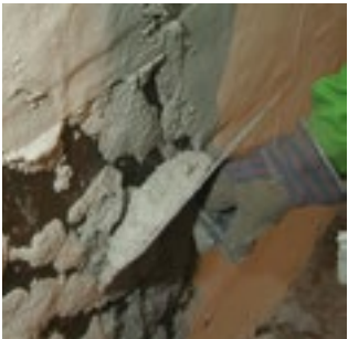
Aufbringen des KÖSTER Sanierputzes
