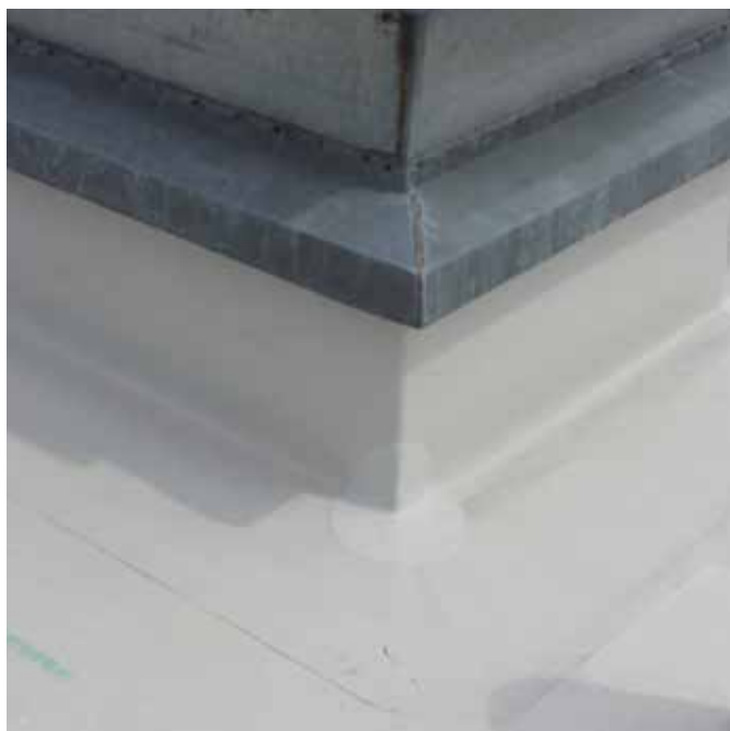
Anschlüsse an rechtwinklige Durchdringungen
