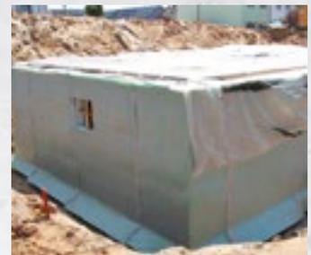
Dichtungsbahnen zur Bauwerksabdichtung und für den Einsatz im Trinkwasserbereich
