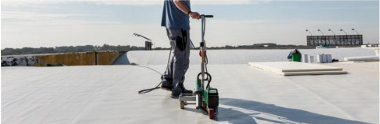
KÖSTER TPO-Dachabdichtungsbahnen eignen sich für die mechanisch befestigte, lose verlegte und vollflächig verklebte Abdichtung von Flach- und Gründächern. Sie zeichnen sich durch eine hervorragende Verarbeitbarkeit und herausragende mechanische Werte sowie ihre Langlebigkeit und Umweltfreundlichkeit aus. KÖSTER stellt thermoplastische Polyolefinbahnen (TPO) und Ethylen-Copolymer-Bitumen-Bahnen (ECB) her. Die Standardfarbe der KÖSTER TPO-Bahnen ist hellgrau, ECB-Bahnen sind schwarz.
