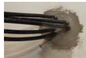
6. ... und dauerhaft abgedichtet.
