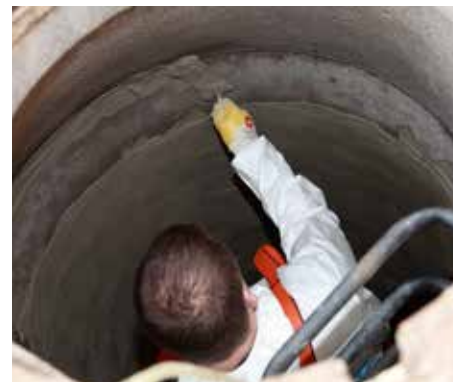
Anschluss des Abwasserschachtes an den Einstiegsbereich
