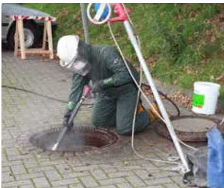
Untergrundvorbereitung (hier Hochdruckwasserstrahlen)
