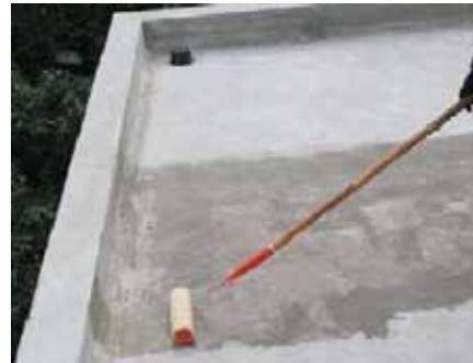
Grundierung mit KÖSTER Polysil® TG 500
