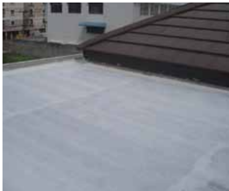
Auftragen der ersten Lage
