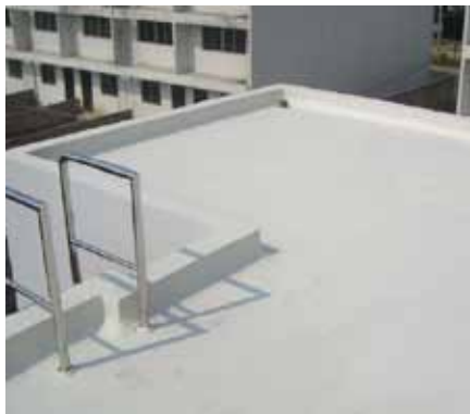
Fertige Dachabdichtung
