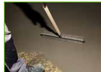
6. Abschließend das Material mit einer Stachelwalze entlüften.
