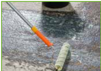
2. Grundierung mit KÖSTER SL Primer
