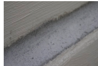
2. Hohlkehle mit KÖSTER Sperrmörtel
