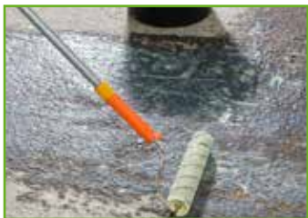
2. Grundierung mit KÖSTER SL Primer
