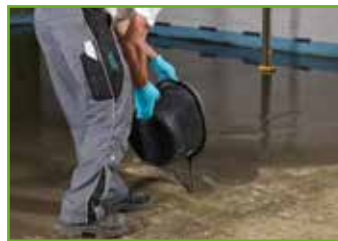
4. Direkt nach dem Anmischen in gewünschter Schichtdicke verteilen
