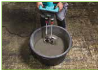
3. Mit geeigneten Rührwerk mindestens drei Minuten intensiv mischen
