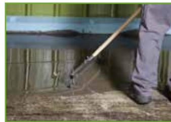
5. Auf größeren Flächen wird die Bodenausgleichsmasse mit einem Zahnrakel verteilt
