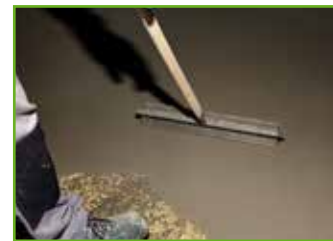
6. Abschließend das Material mit einer Stachelwalze entlüften
