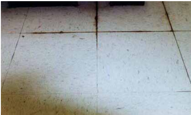
Feuchtigkeit und hoher pH Wert lösen Kleber auf...
