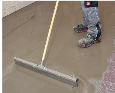
5 Auf größeren Flächen wird die Bodenausgleichsmasse mit einem Zahnrakel verteilt
