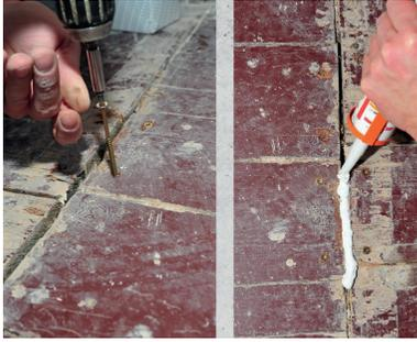
1 Untergrundvorbereitung: Befestigung loser Dielen und Verschließen von Fehlstellen
