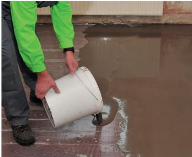
4 Direkt nach dem Anmischen (mind. 3 Minuten) in gewünschter Schichtdicke verteilen
