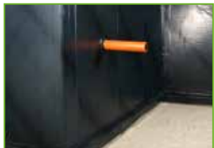
Die Abdichtung ist installiert.
