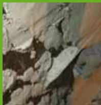
Aufbringen des KÖSTER Sanierputzes
