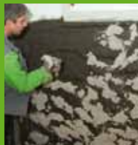
Aufbringen des KÖSTER Spritzbewurfs
