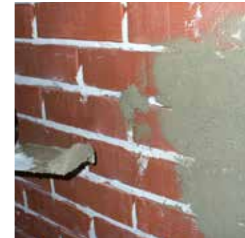
3 Fehlstellenausgleich mit KÖSTER Sperrmörtel WU
