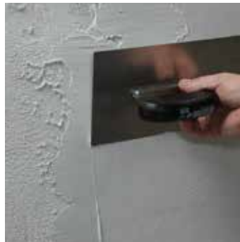
5 Oberflächenputz mit KÖSTER Sanierputz
