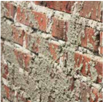
4 Haftspritzbewurf mit KÖSTER Sanierputz Spritzbewurf
