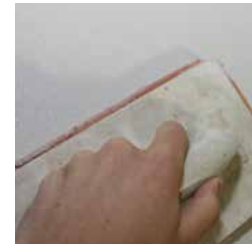
6 Oberflächengestaltung mit KÖSTER Feinputz
