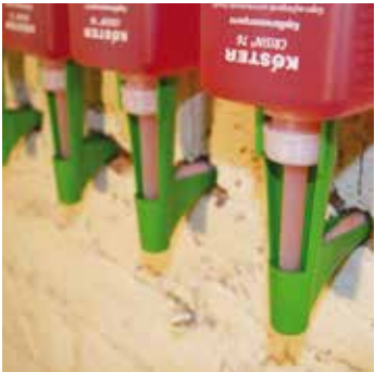
1 Horizontalsperre mit KÖSTER Crisin 76 Konzentrat
