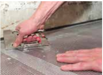
3. Aufbringen von KÖSTER Armierungsgewebe auf den Holzuntergrund
