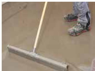
5. Auf größeren Flächen wird die Bodenausgleichsmasse mit einem Zahnrakel verteilt
