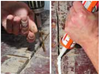
1. Untergrundvorbereitung: Befestigung loser Dielen und Verschließen von Fehlstellen
