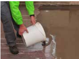
4. Direkt nach dem Anmi- schen (mind. 3 Minuten) in gewünschter Schichtdicke verteilen
