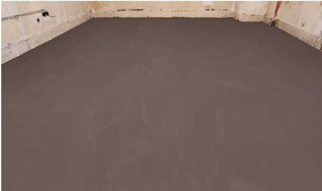
Das Ergebnis: ein schnell und sicher ausgeführter dauerhafter Bodenausgleich
