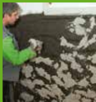
Aufbringen des KÖSTER Spritzbewurfs
