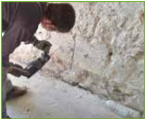
Alle 10 bis 15 cm wird bis 5 cm vor Mauerwerksende gebohrt
