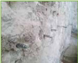
Der Bohrlochdurchmesser richtet sich nach den eingesetzten Packern
