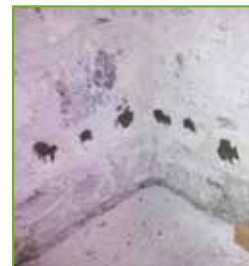
Anschließend werden die Bohrlöcher mit KÖSTER KB-Fix 5 verschlossen.
