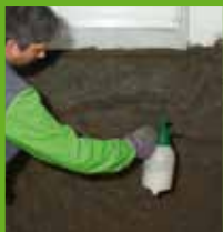
Grundieren mit KÖSTER Polysil TG 500
