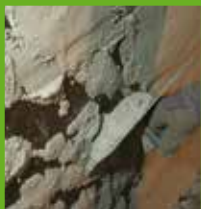
Aufbringen des KÖSTER Sanierputzes
