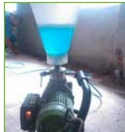
Die Verpressung erfolgt im Niederdruckverfahren mit der KÖSTER 1K-Injektionspumpe
