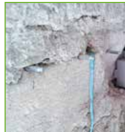
Bis zur Gelphase, die nach 45-60 Minuten einsetzt, ist ein Nachinjizieren möglich
