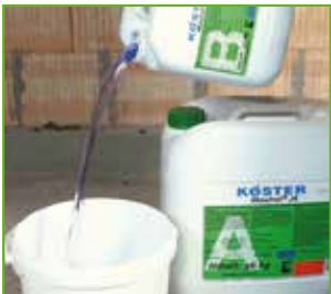
Beide Komponenten bis zum Erreichen einer homogenen Konsistenz vermischen
